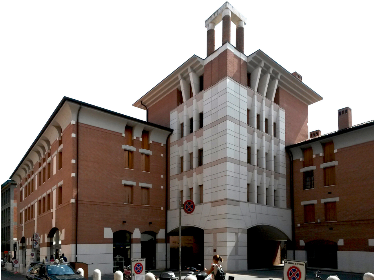
Fig. 4b - Arch. A. Natalini, ricostruzione dell'angolo di un isolato nel centro storico di Ferrara.
