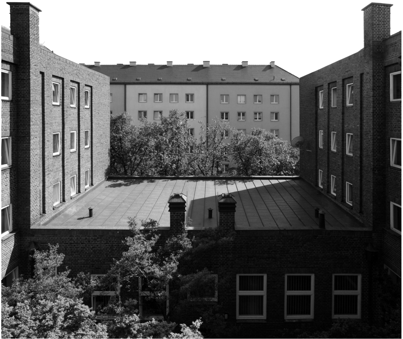
Fig. 7 - Ledigenheim, vista dalla corte interna (foto N. Panzini, 2012).
