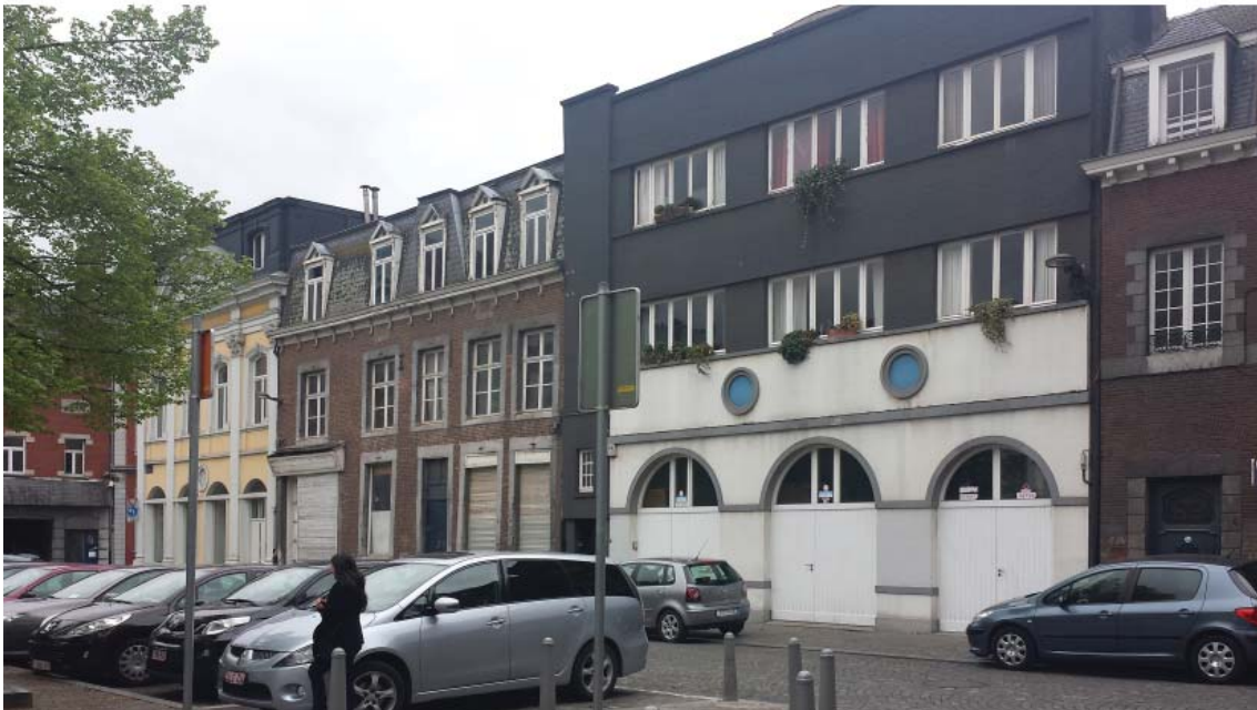
Fig. 1. Liegi, Place Saint Barthélemy. Tessuto di formazione seicentesca, parzialmente trasformato, oggetto di sostituzione edilizia
