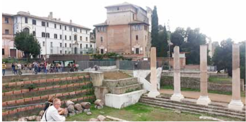
Fig. 11 - Stato di fatto. Current situation of site.
